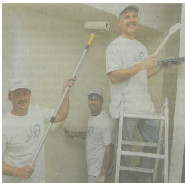
Drei ELE-Mitarbeiter und ein Gelsen-Net-Mitarbeiter legten im „The Point“ fleißig Hand an. Foto: Fremdbild
